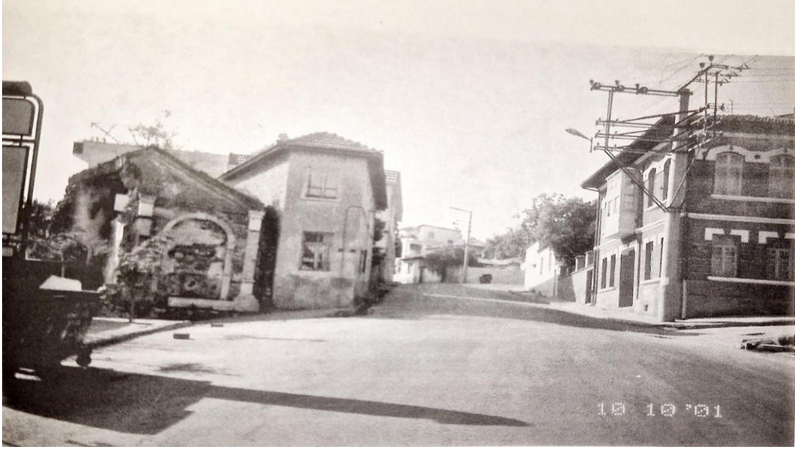
Fotoğraf 31: Evler köprülü mahallesi sebil sokakta bulunmaktadır. Fotoğrafın solundaki sebil osmanlı döneminden kalma bir yapıdır. evler ise 20. yüzyıla ait yapılardır. aydın'da tarihi konutların en yoğun olduğu sokaklardan biridir.
